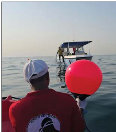
فريق الغوص أثناء تركيب مرابط بحرية بجيزة كبر
