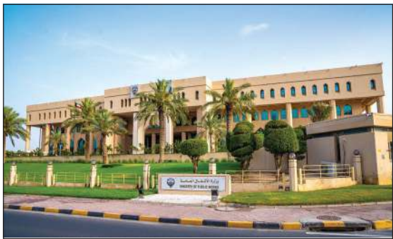
مبنى وزارة الأشغال
