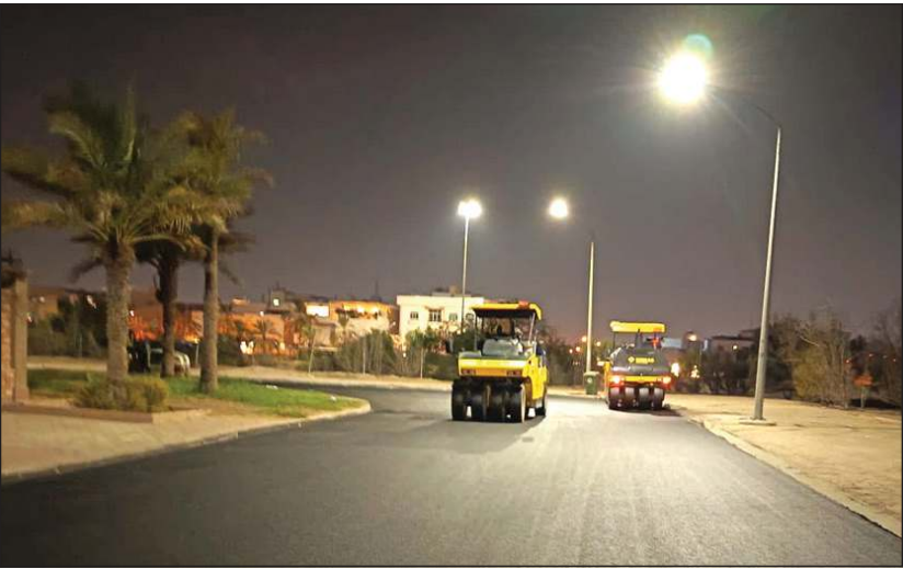
جانب من أعمال صيانة الطرق
