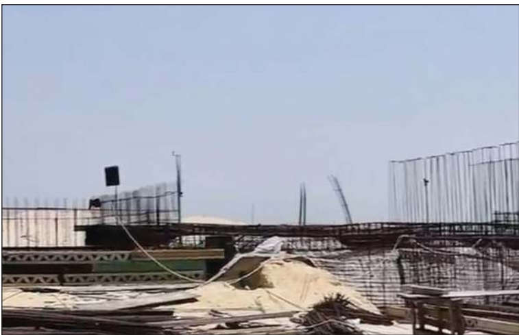
جانب من أعمال الإنشاءات
