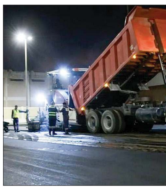
جانب من أعمال الصيانة الجذرية للطرق بمنطقة الدسمه
