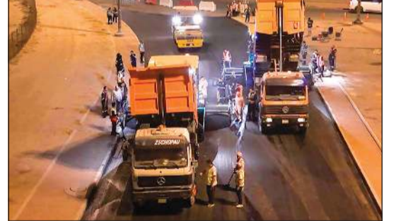
صورة أرشيفية لأعمال صيانة الطرق في إحدى المناطق
