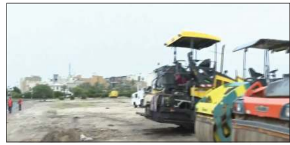
جانب من أعمال صيانة الطرق
