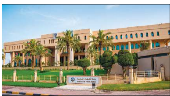
مبنى وزارة الأشغال
