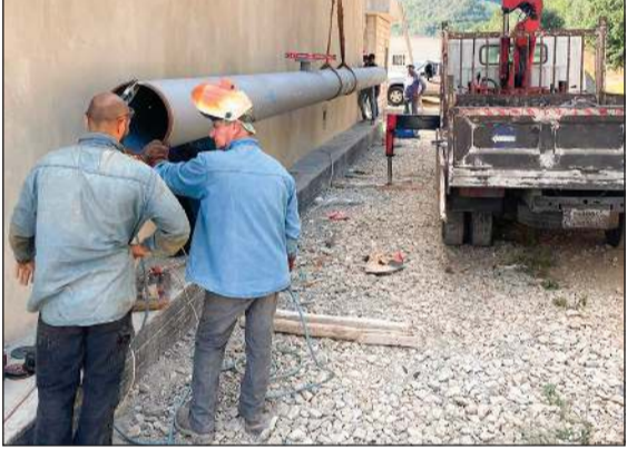
تركيب أنابيب المياه من الآبار الارتوازية إلى محطة الضخ (محمود الطويل)
