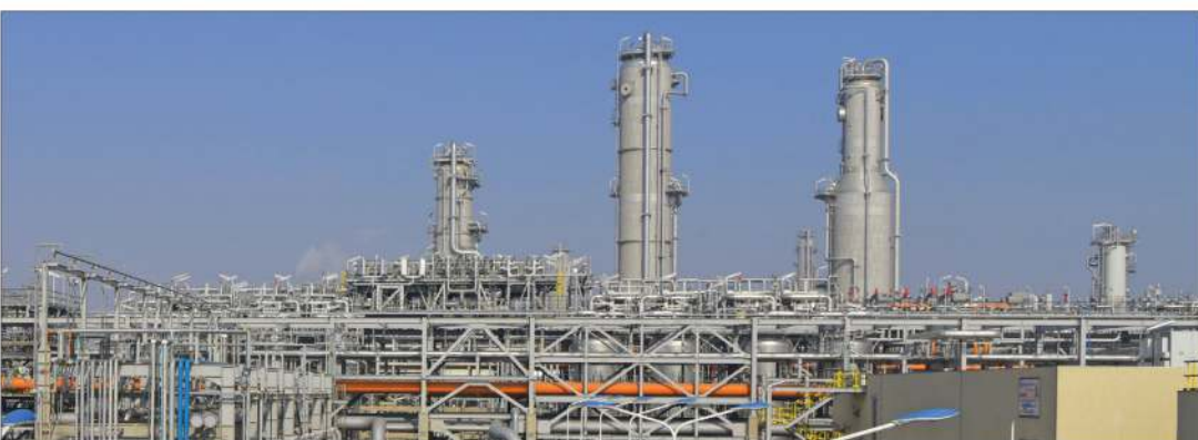
خط الغاز المسال الخامس بمصفاة ميناء الأحمد
