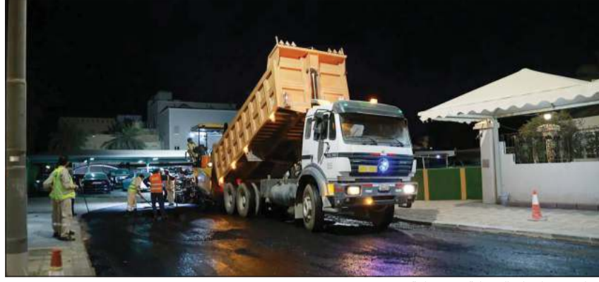
جانب من أعمال الصيانة في منطقة مشرف
