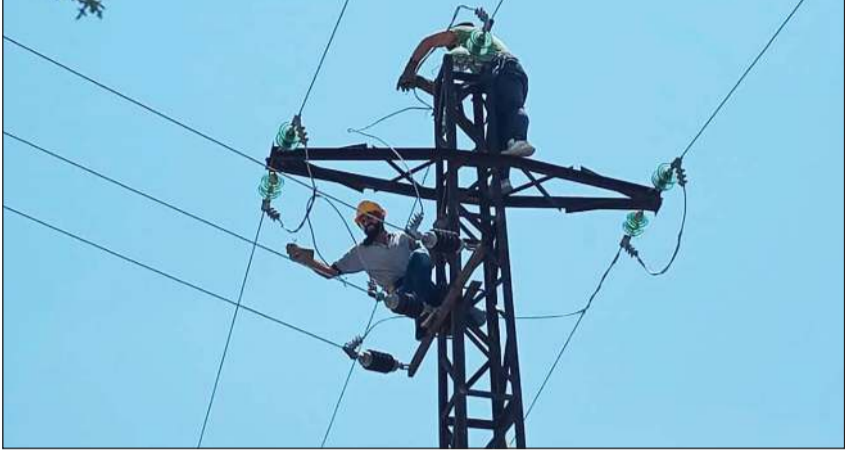
صورة نشرتها قناة الاخبارية لأعمال صيانة شبكة الكهرباء في السويداء
