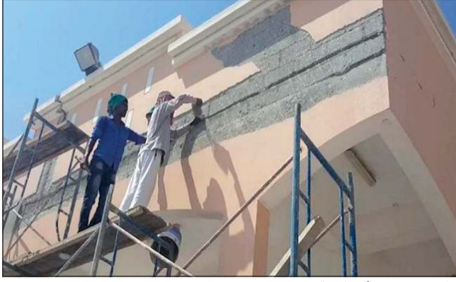
جانب من ترميم أحد المساكن
