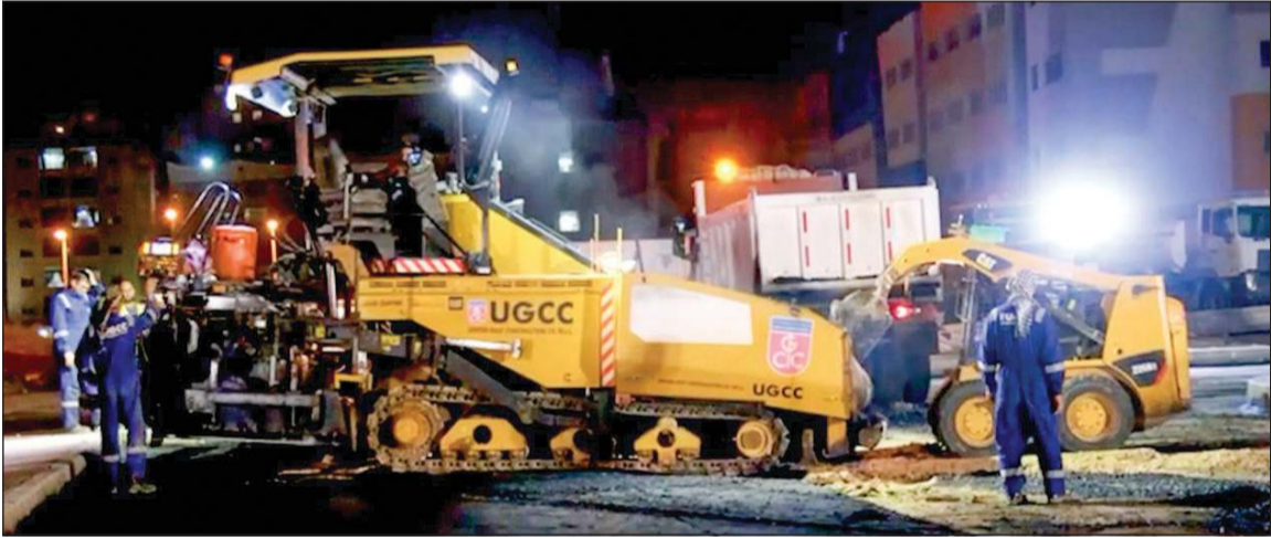
جانب من أعمال صيانة الطرق في منطقة المنقف
