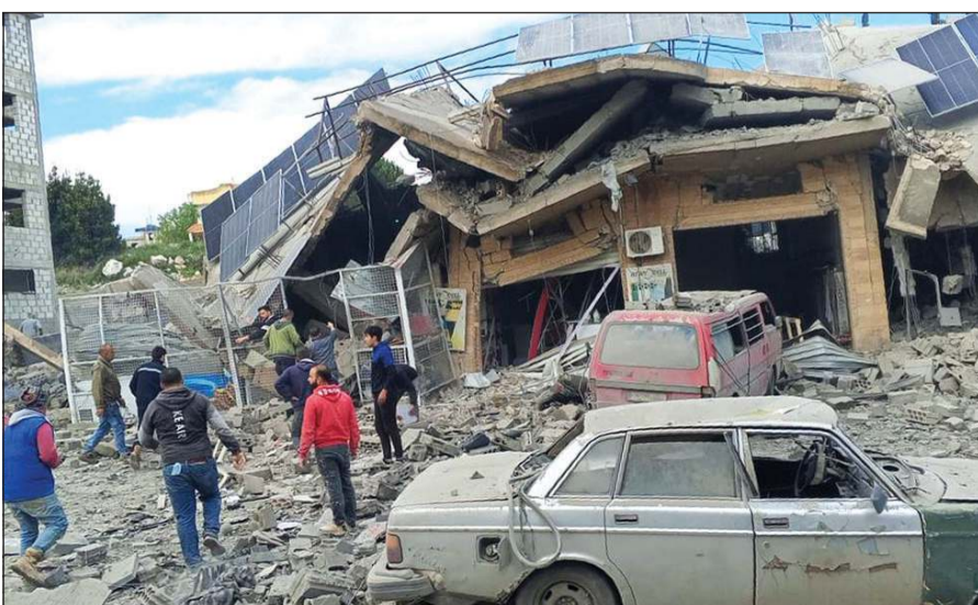
آثار الدمار في بناء جراء غارة إسرائيلية استهدفت بلدة تولين جنوب لبنان (محمود الطويل)
