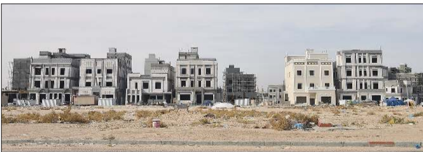
جانب من أعمال البناء والإنشاء في مدينة المطلاع
