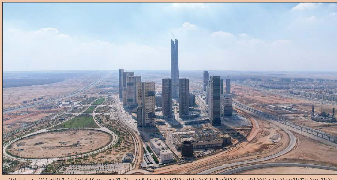
لقطة جوية ملتقطة يوم 28 يونيو 2023 تظهر منطقة الأعمال المركزية بالعاصمة الإدارية الجديدة في مصر التي تقع على بعد 45 كيلومترا شرق القاهرة (نشر عبر شينخوا)
