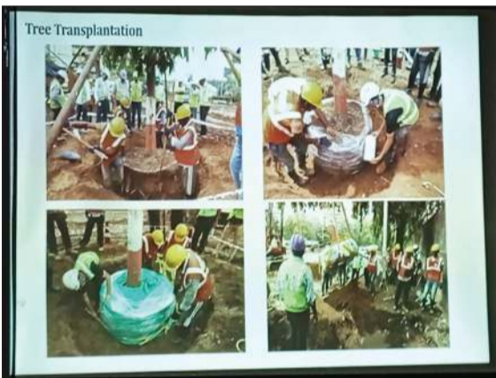
عملية نقل إحدى الأشجار من مسار خط المترو
