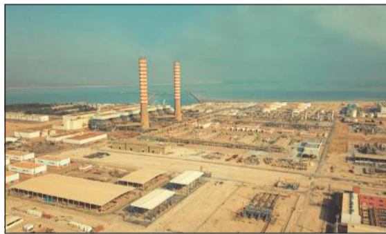
محطة كهرباء الصبية
