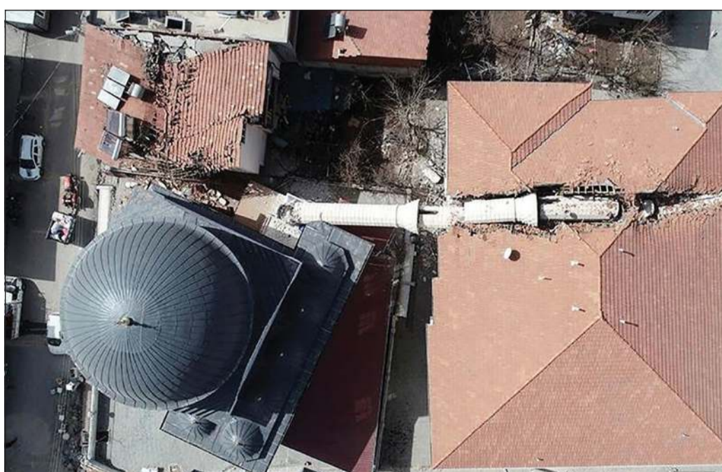
صورة جديدة لمنطقة جامع «الحاج غني ديار» الذي تم بناؤه عام 2021 والتي سقطت فوق مبنى من ط 3 طوابق وشطرته قسمين في ادي يامان (الأناضول)
