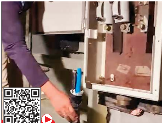
توصيلات لسرقة التيار الكهربائي
