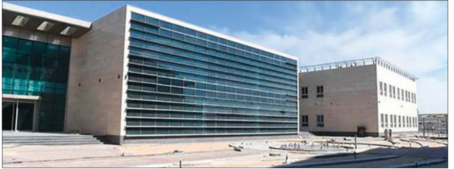
مبنى الإدارة العامة لأمن المنشآت
