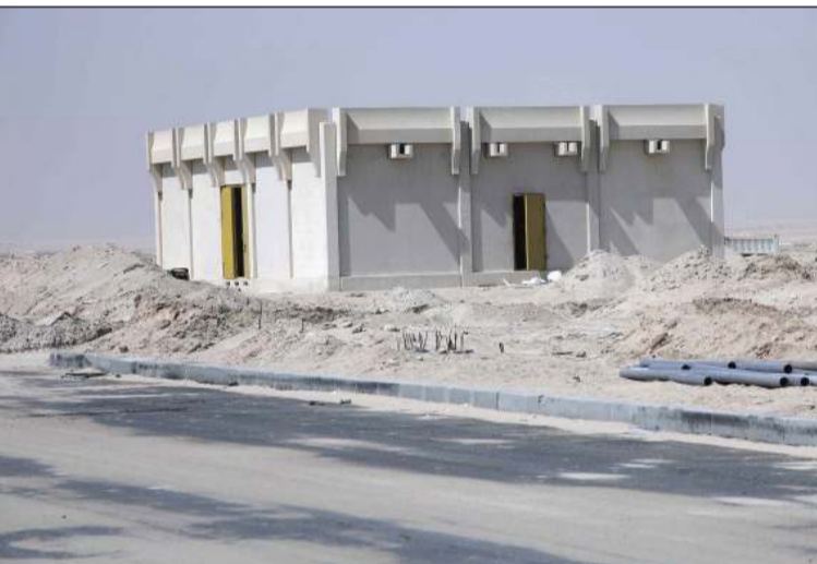
أحد مباني الخدمات العامة في مشروع المساكن منخفضة التكاليف
