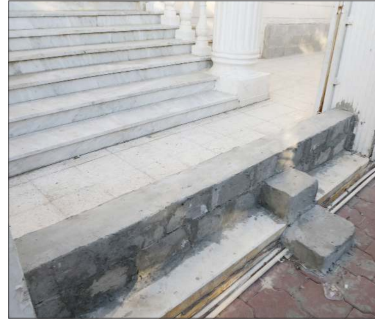
.. وبناء عتبات للمنازل تقاديا لدخول المياه
