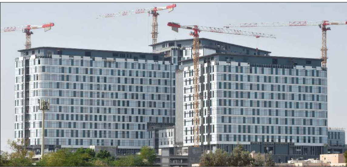
جانب من أعمال البناء في مشروع مستشفى الولادة الجديد
