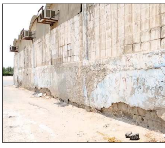
جانب من المبنى
