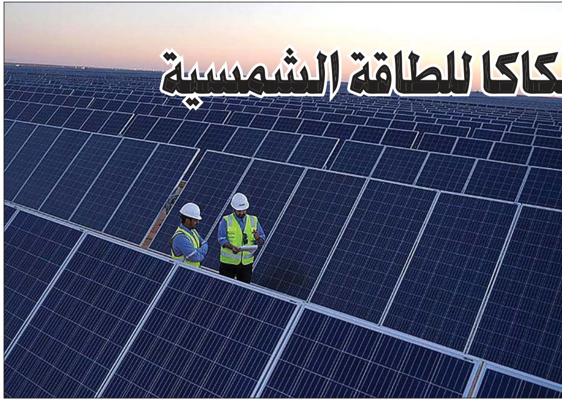
جانب من مشروع محطة سكاكا لإنتاج الكهرباء من الطاقة الشمسية (واس)
