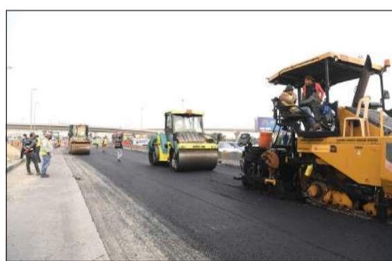
جانب من أعمال المشروع
