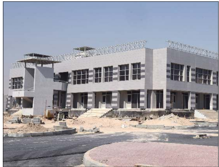
إنجاز التغطية الخارجية لأحد المباني
