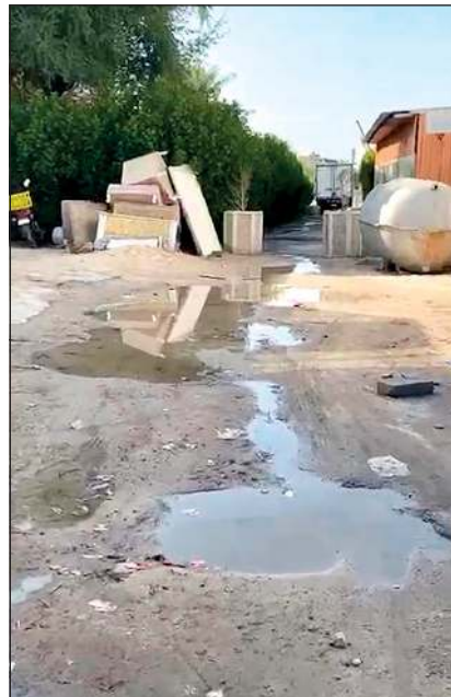
طفح مياه الصرف بين المنازل في المنطقة
