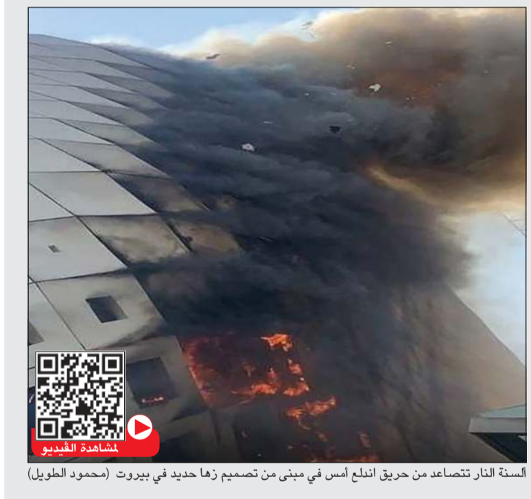
السنة النار تتصاعد من حريق اندلع أمس في مبنى من تصميم زها حديد في بيروت (محمود الطويل)
