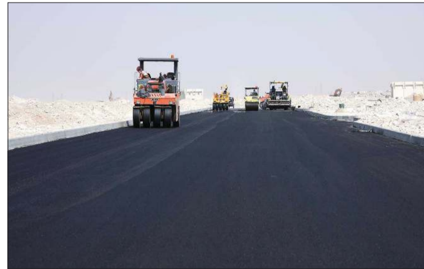
جانب من أعمال الإسفلت في طرق المشروع
