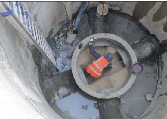
من أعمال شبكة الصرف
