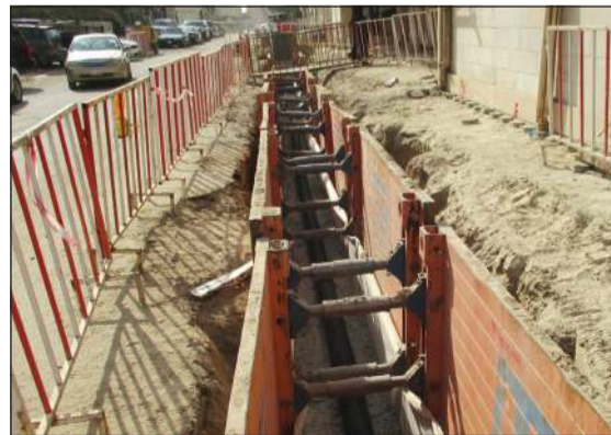
تنفيذ شبكات الكهرباء والهاتف
