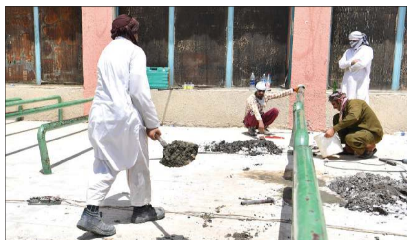
عمال يقومون ببعض أعمال الصيانة والإصلاح
