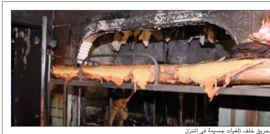
الحريق خلف تلفيات جسيمة في المنزل
