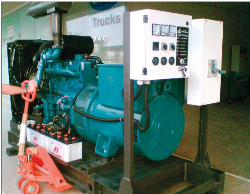
مولد كهرباء ديزل
