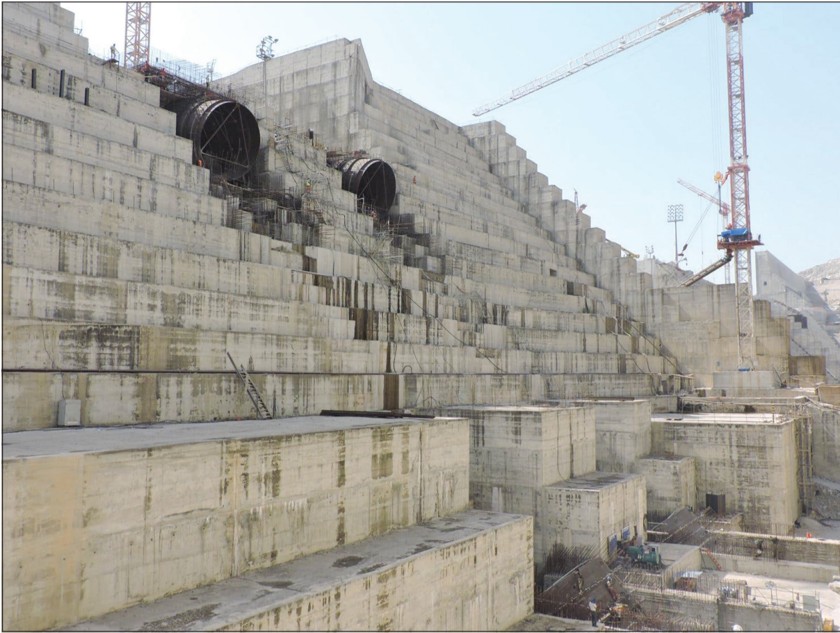
إحدى الصور التي نشرتها إثيوبيا لاستكمال بناء سد النهضة
