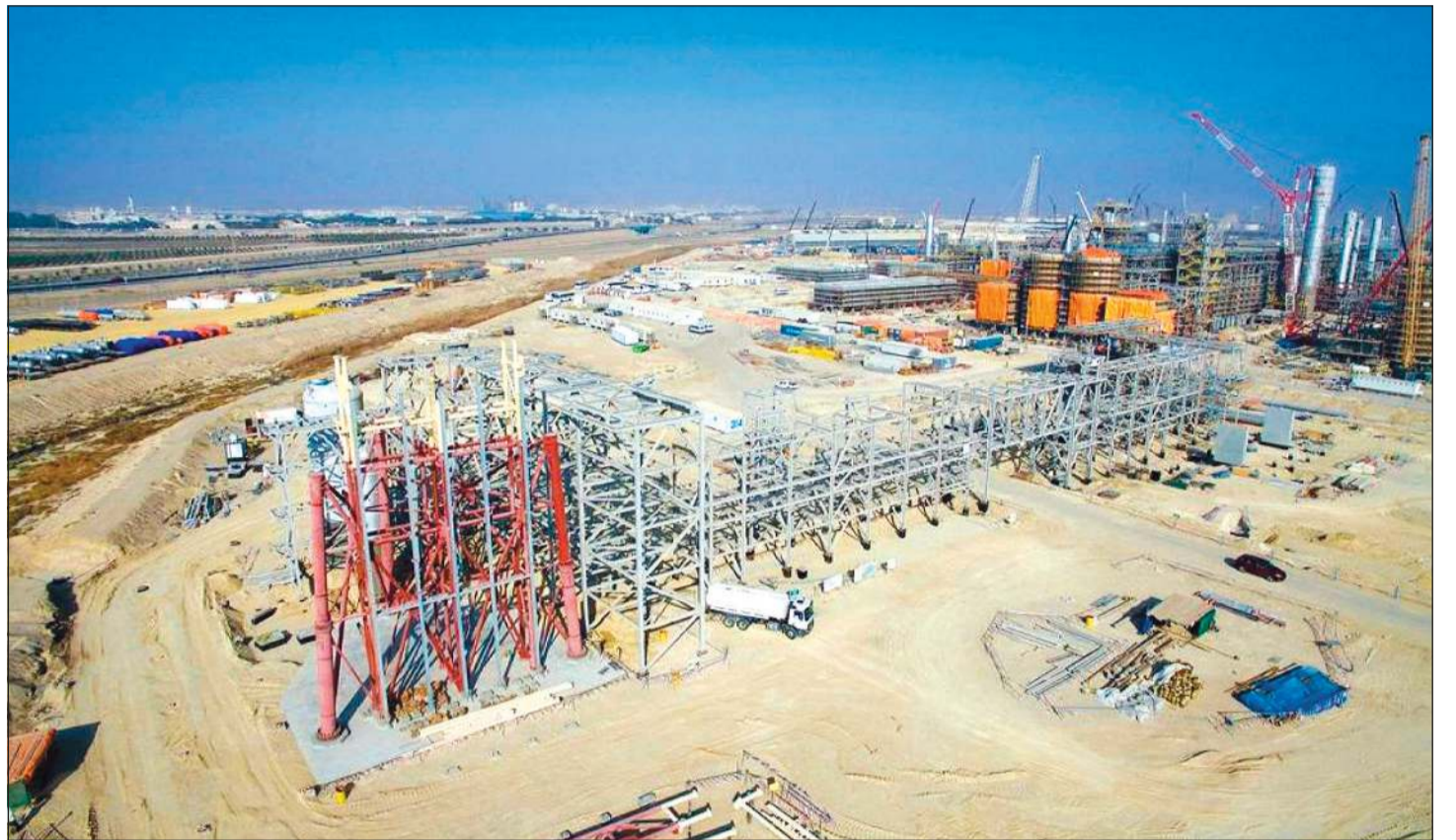
جانب من عمليات الإنشاء في مشروع الوقود البيئي
