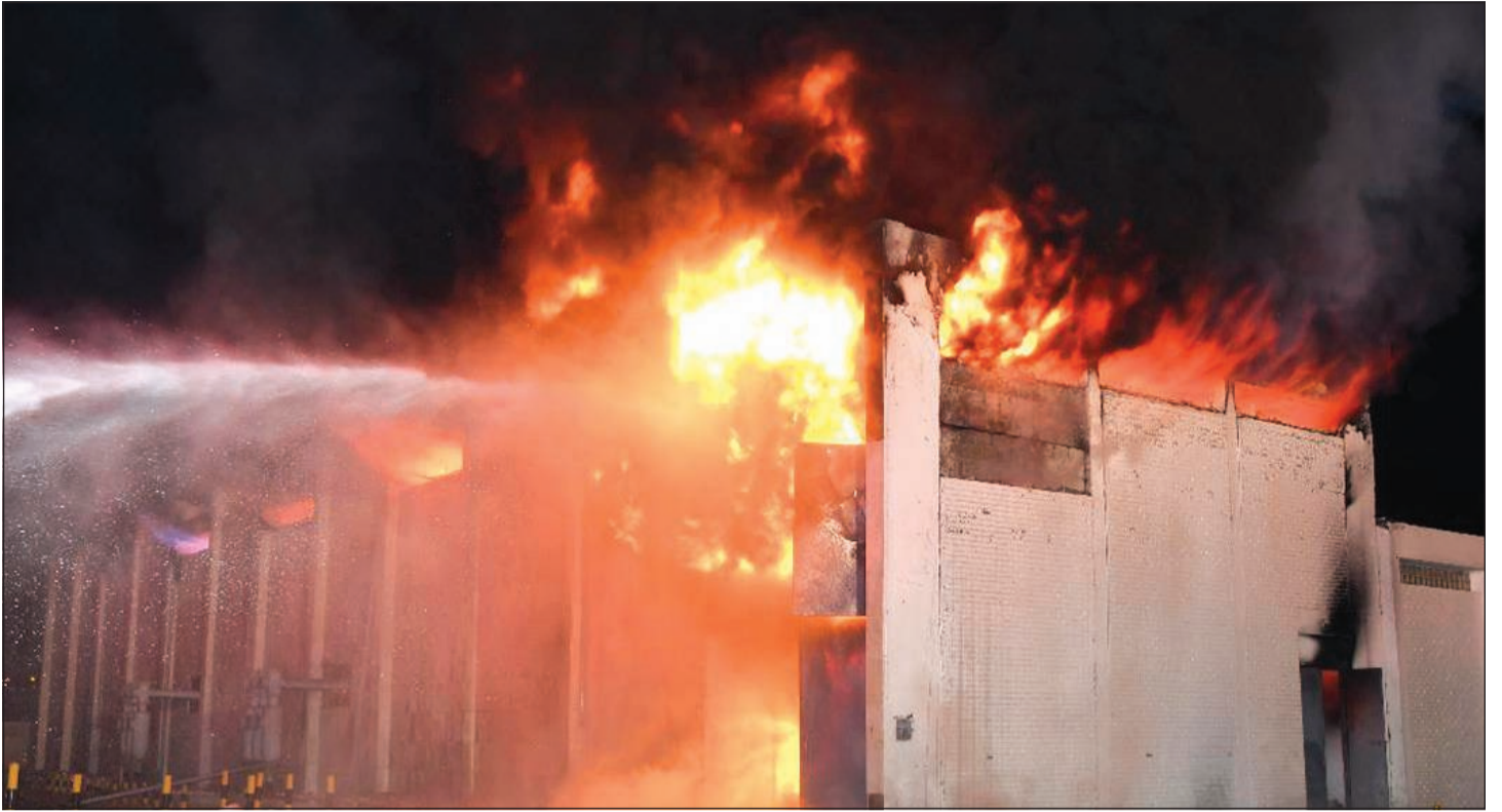
حريق المحول فصل التيار الكهربائي لمدة تصل إلى 40 دقيقة
