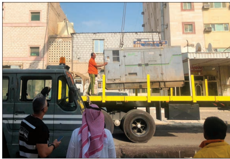
رفع مولد كهربائي في المنطقة 4
