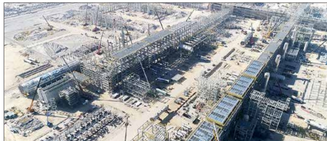
جانب من تنفيذ الأعمال في مشروع مصفاة الزور
