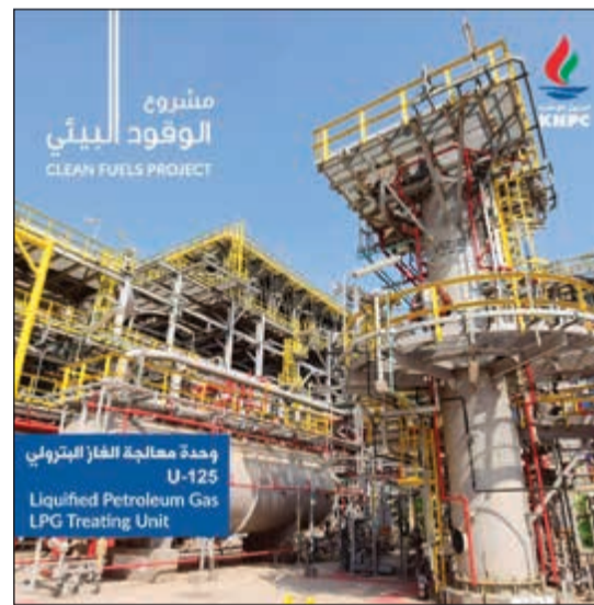
إحدى وحدات مشروع الوقود البيئي التي أدخلتها شركة البترول الوطنية أمس الأول
