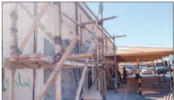
جانب من عملية ترميم مبنى مركز نظافة «الروضة»
