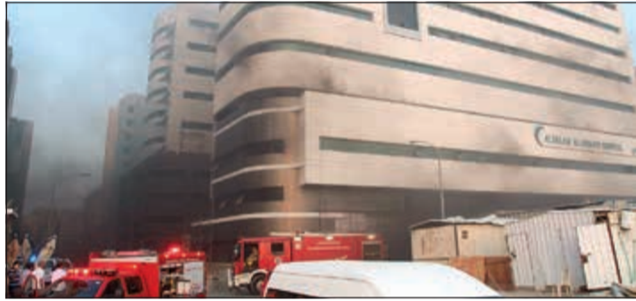
الحريق خلف سحباً دخانية كثيفة
