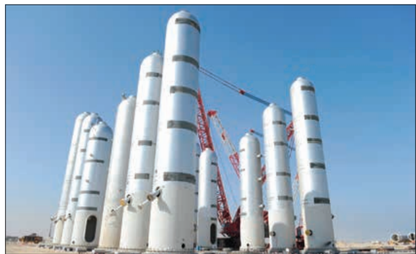
جانب من عمليات التشييد في مصفاة الزور الجديدة
