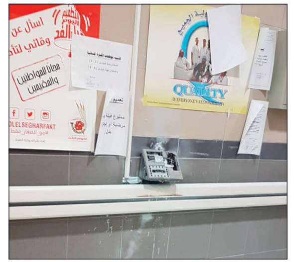
جهاز البصمة وقد اتلف كلياً بفعل الحريق
