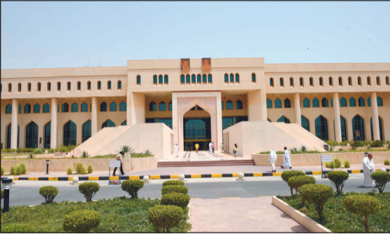
مبنى وزارة الكهرباء والماء
