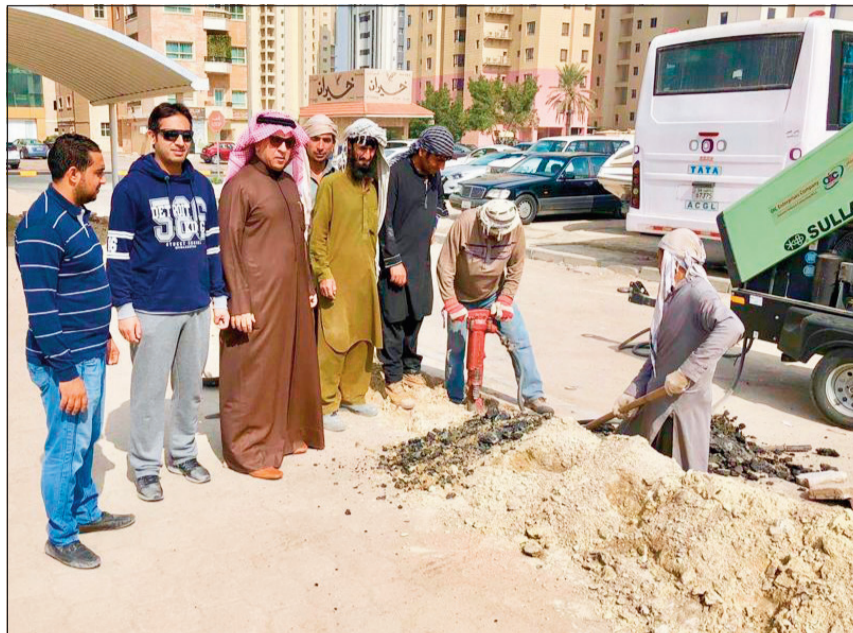
جانب من أعمال الحفر في محيط مبنى قسم التلفزيون بتواجد د.العنزي ووكيل المعهد د.حسين الحكم
