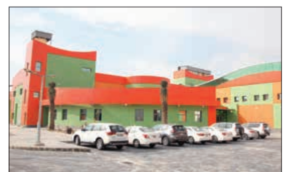
مبنى روضة الشهداء بعد اكتمال إنشائه (زين علام)
