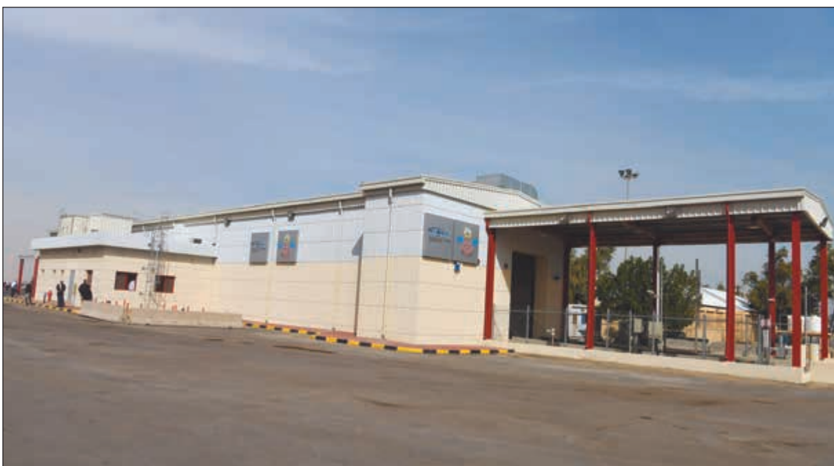
مبنى تفتيش الشاحنات «الجنريتر» يستوعب شاحنتين للتفتيش في وقت واحد
